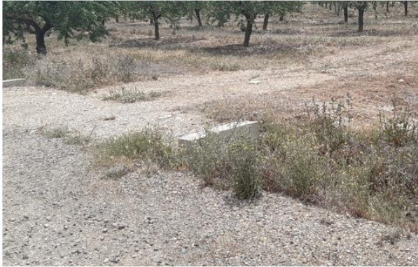
Fig. 1 Tubo de drenaje semitaponado con vegetación arbustiva en vial de acceso al aereo ML3.06. Fuente: Elaboración propia
